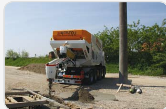
ZS1260 auf der Baustelle
